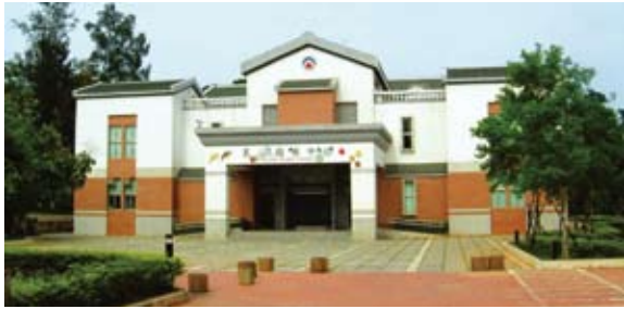
(左) 圖8 乳山遊客中心利用建築物的高低落差達到通風與自然光採用
